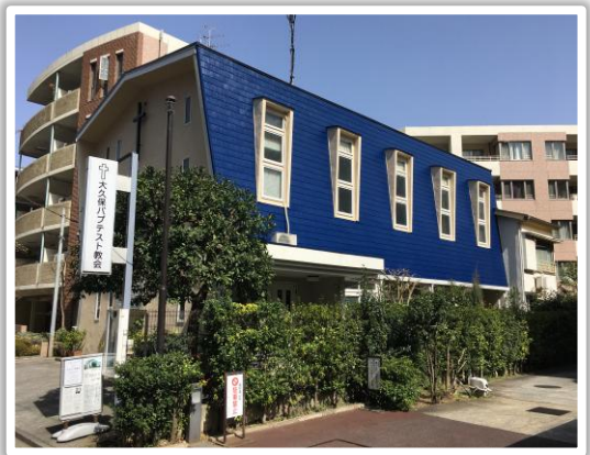
塗装が施されて、きれいになった教会外観
