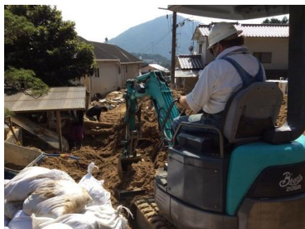
重機による土砂撤去
