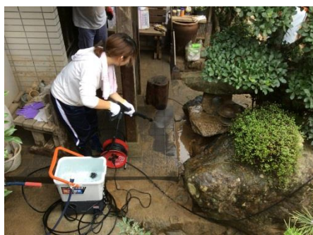
高圧洗浄機による清掃
