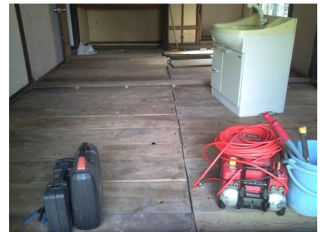
土砂を撤去、床板を戻しました。
