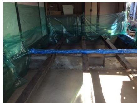
撤去終了！※左写真の隣室
