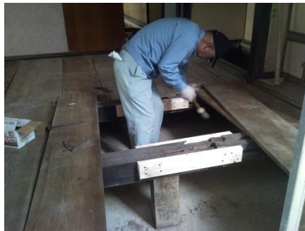
床下大引の補強
