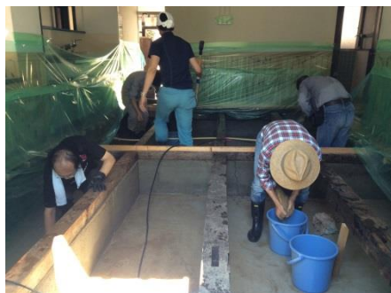
部屋内を養生して撤去作業
