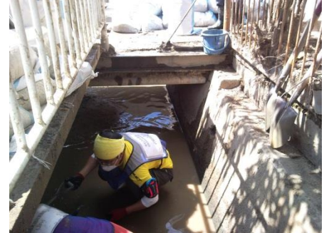
重機が入れない場所は人力です。
