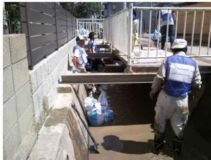
用水路の土砂撤去
