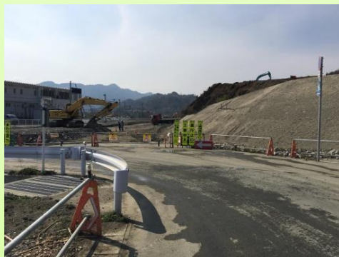
まだまだ続く嵩上げ工事
