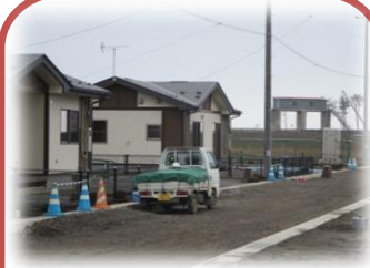
新しい復興住宅(奥に水門)
