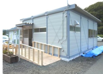
第7仮設談話室 新築
