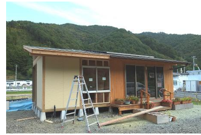
第4仮設談話室 増築(左側)
