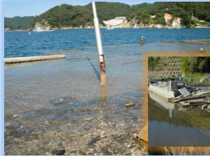
牡鹿半島の牧浜と月浦の冠水の様子。震災で地盤沈下したため、満潮時には漁港に海水が上がってきて水浸しになります。漁港を再建するには、まずかさ上げしなければいけません。
