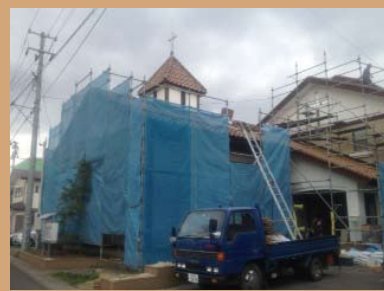
●瓦補修のため足場が組まれた郡山コスモス通り教会の外観
