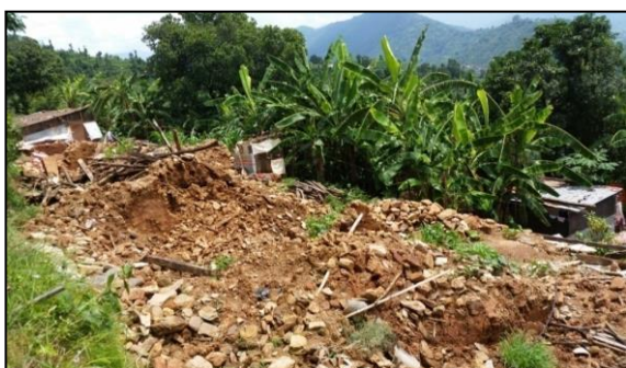
倒壊した家と土地のきわに、救援物資の錆びたトタンをかけただけの仮設で生活が続いている。
