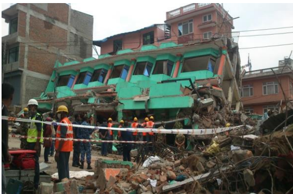
▲倒壊したダーシャム教会。20名が亡くなった
